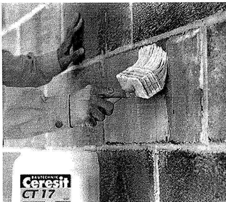
Рисунок 9 – Нанесение грунтовки при помощи кисти-макловицы
