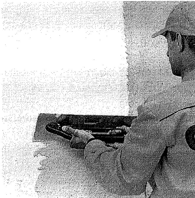
Рисунок 38 – Нанесение штукатурки металлической теркой
